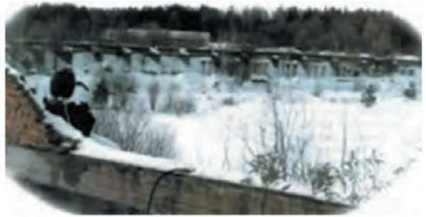
Все, что осталось от купола после обрушения
