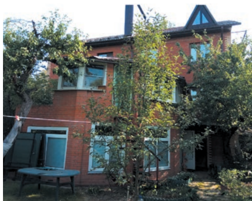
Вид сзади на пристройку с бассейном
