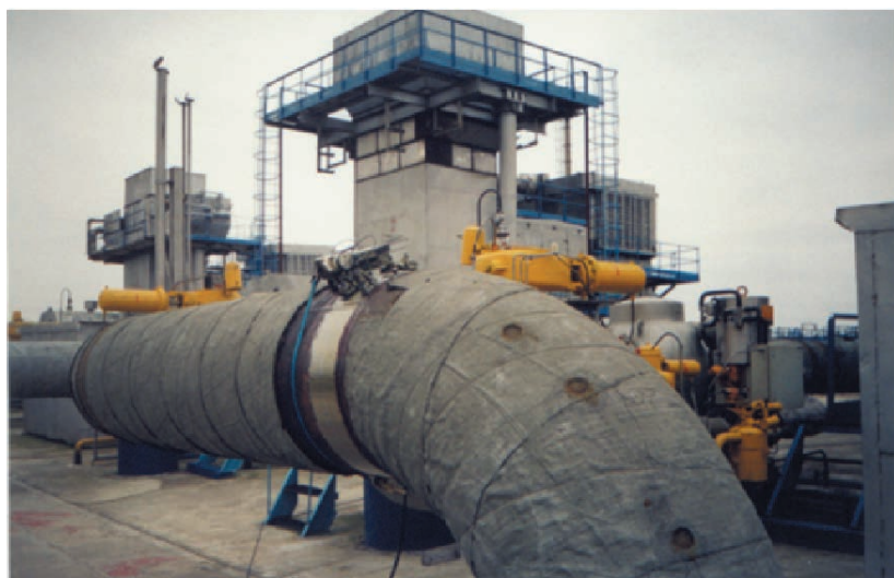
Контроль трубопровода в Трассгаз «Чайковский». 2003 год
