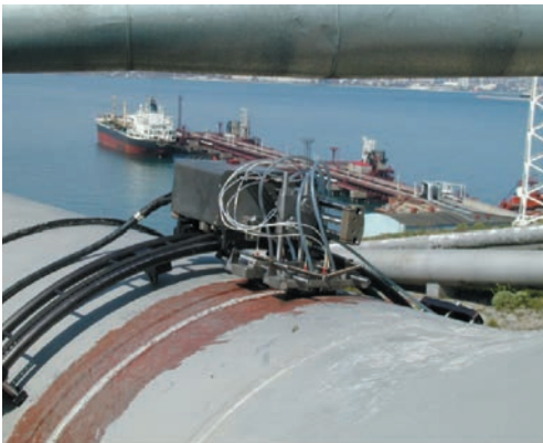
Диагностика нефтепровода на нефтебазе «Шисхарис» (Новороссийск)
